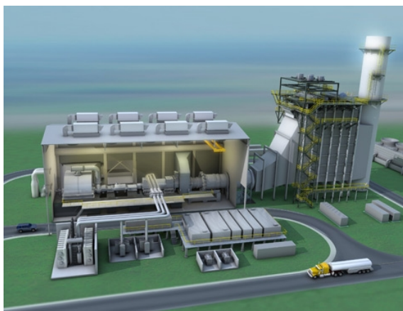
Рис. 4. Газотурбинная электростанция комбинированного цикла
